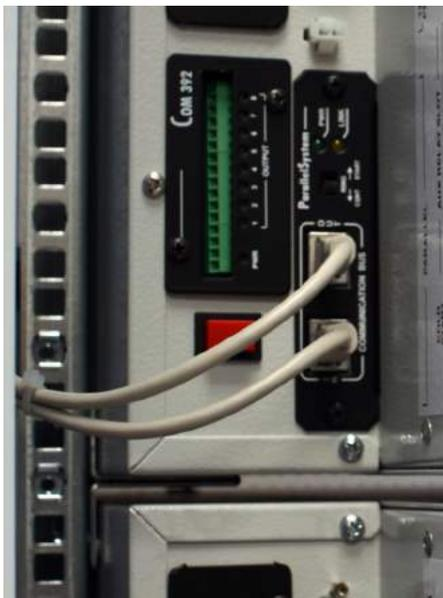
Параллельное подключение и плата контактов программируемых реле
