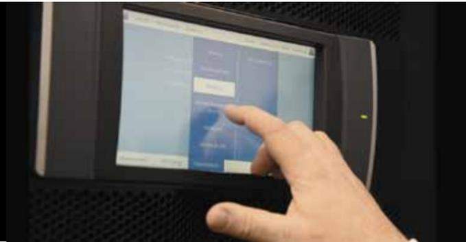
ИБП Delta Modulon серии DPH позволяют просматривать на сенсорной панели до 10 000 записей событий. На 10" ЖК дисплее ИБП в дополнение к данным о состоянии батарей можно просматривать информацию о температуре, охлаждении, протечках воды, срабатывании охранной и пожарной сигнализации. Доступность всей этой информации на сенсорном дисплее облегчает местное управление объектом.
