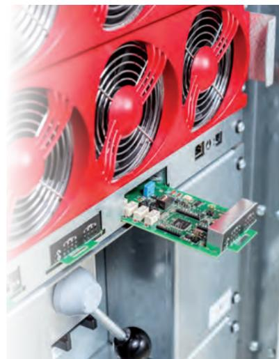
Системы ИБП серии JOVYCUBE сочетают в себе модуль инвертор на 20 кВА с зарядным устройством батареи. Модуль JOVYCUBE можно заменять в рабочем режиме без соблюдения особых приемов работы.
